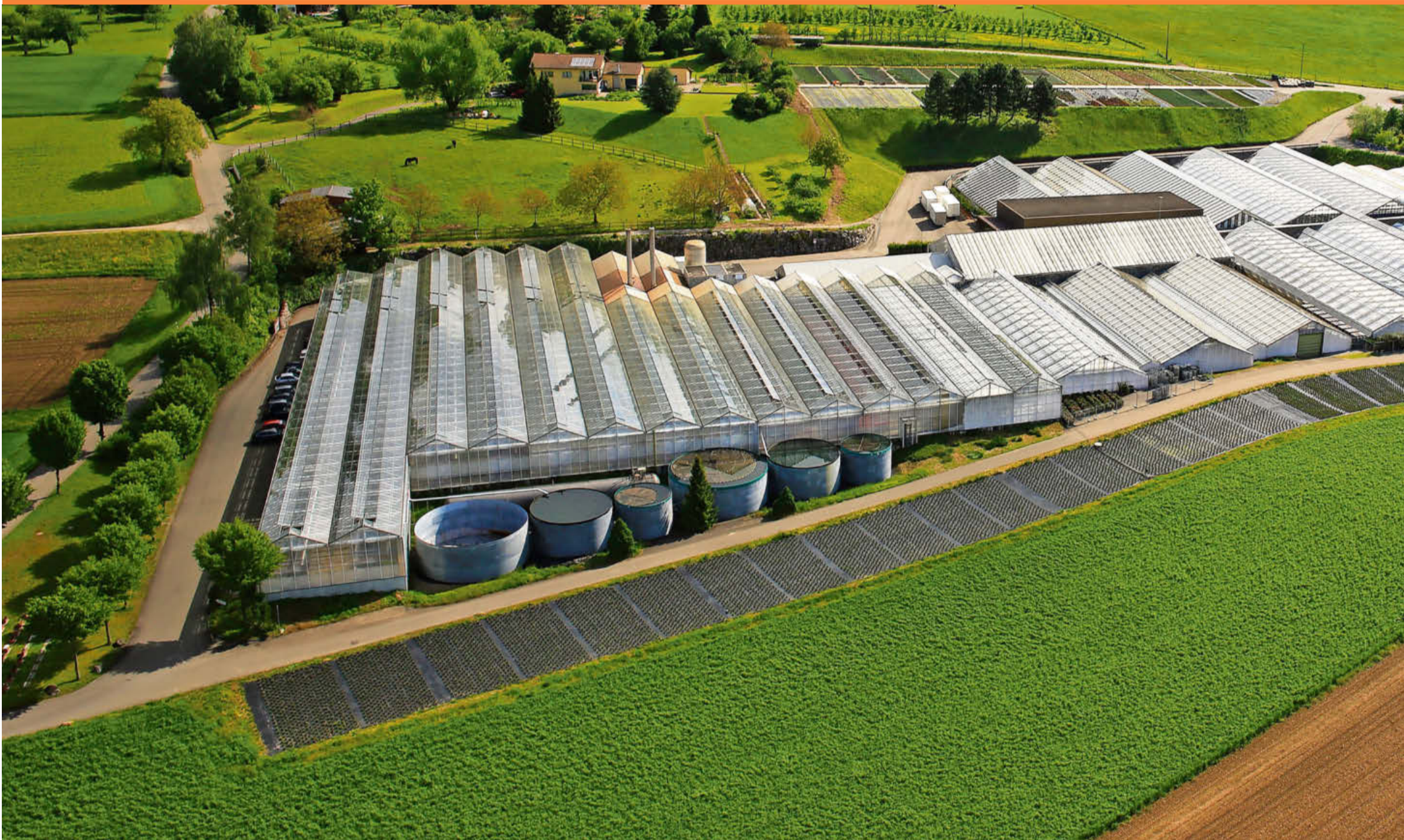
In den letzten Zügen: Rund zwei Drittel der Gewächshäuser der Lamprecht Pflanzen AG mit einer Gesamtfläche von 20 000 Quadratmetern werden abgerissen und neu gebaut.
