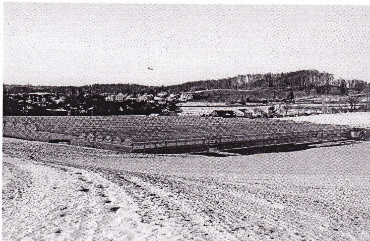
Auf der dunklen Fläche vor den Gewächshäusern im Vordergrund wird im Juni mit dem Bau des neuen Cabriolet-Gewächshauses begonnen.
