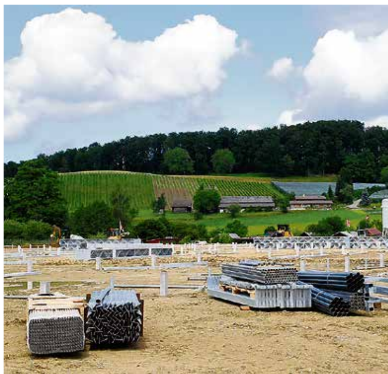
Auf dem Gelände von über 10000 Quadratmetern entstehen zwei neue Gewächshäuser sowie eine Freiland- und Schattenhalle.
